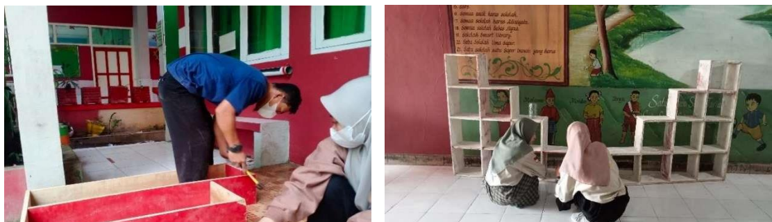
Gambar 4. Pembuatan rak – rak buku untuk di perpustakaan
